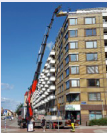
Renovering av lägenhet på hög nivå.
